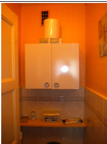
S 1: 6 rue des Corroyers - R+1 - Apt. 33 - WC - Conduits en fibres-ciment (masqué derrière un coffrage) - Photo n°1
