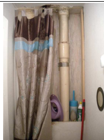
S 2: 6 rue des Corroyers - R+2 - Apt. 35 - WC - Conduits en fibres-ciment - Photo n°2
